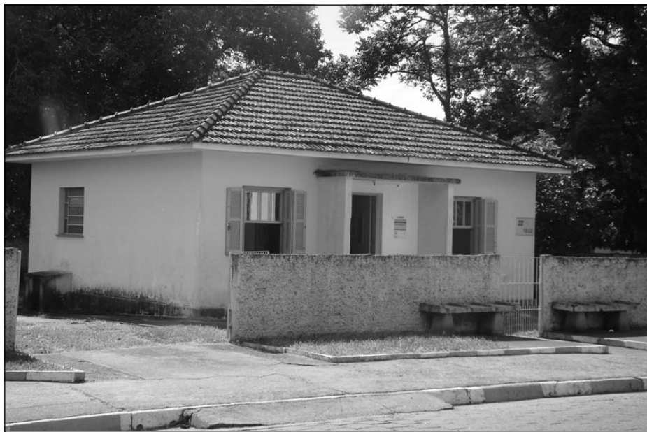
O posto do IBGE em Avaré fica na CAIC (Centro Avareense de Integração Cultural Djanira)
