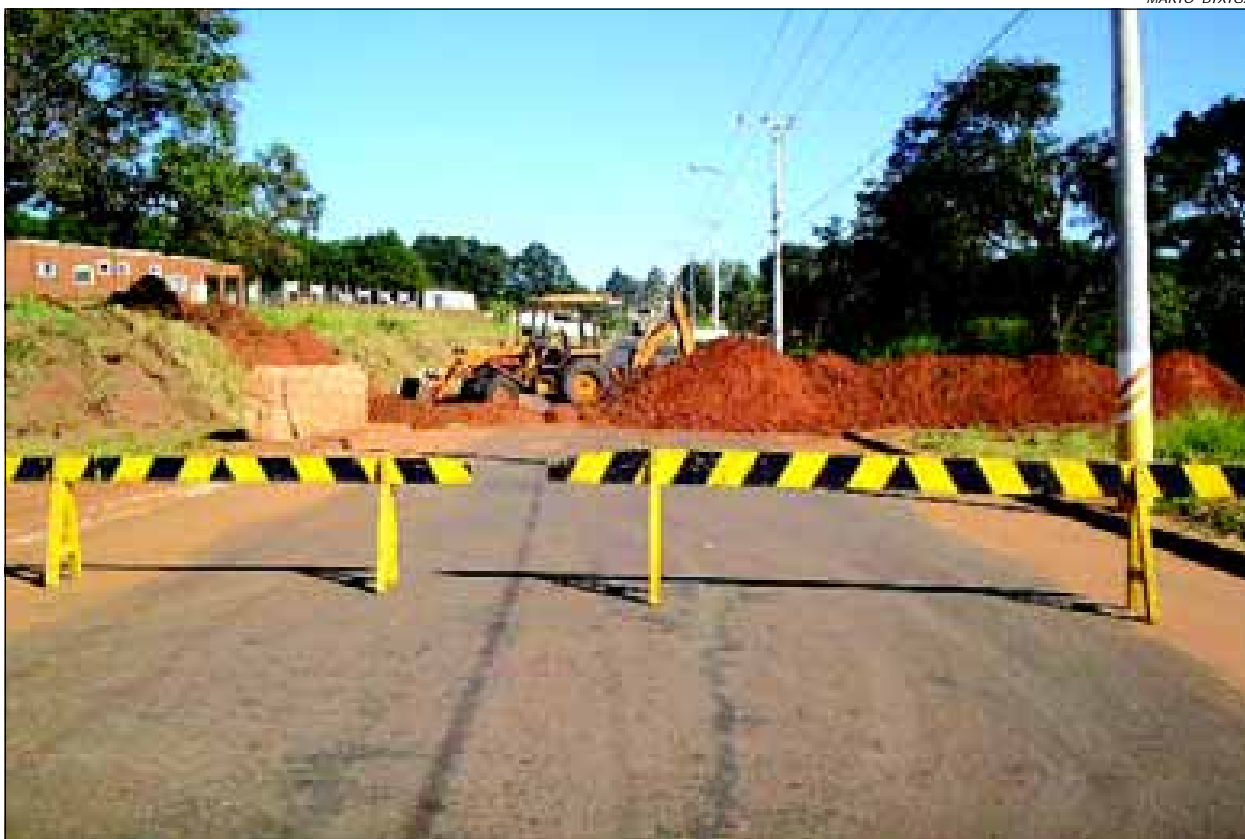
Tubulação contribuirá para captação das águas das chuvas
