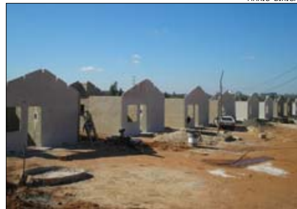
As casas estão sendo construídas pela CDHU
