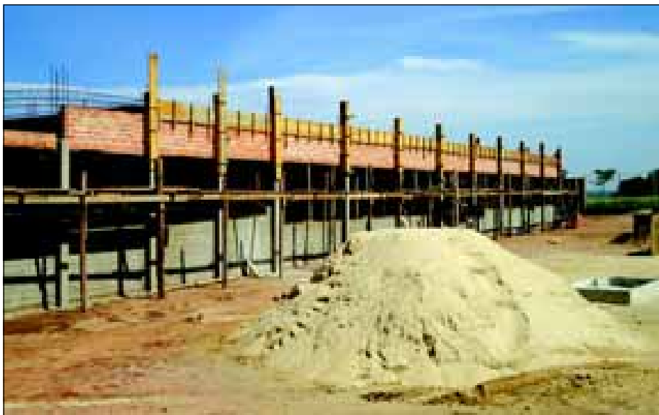
Obras da escola do Bairro Santa Mônica
