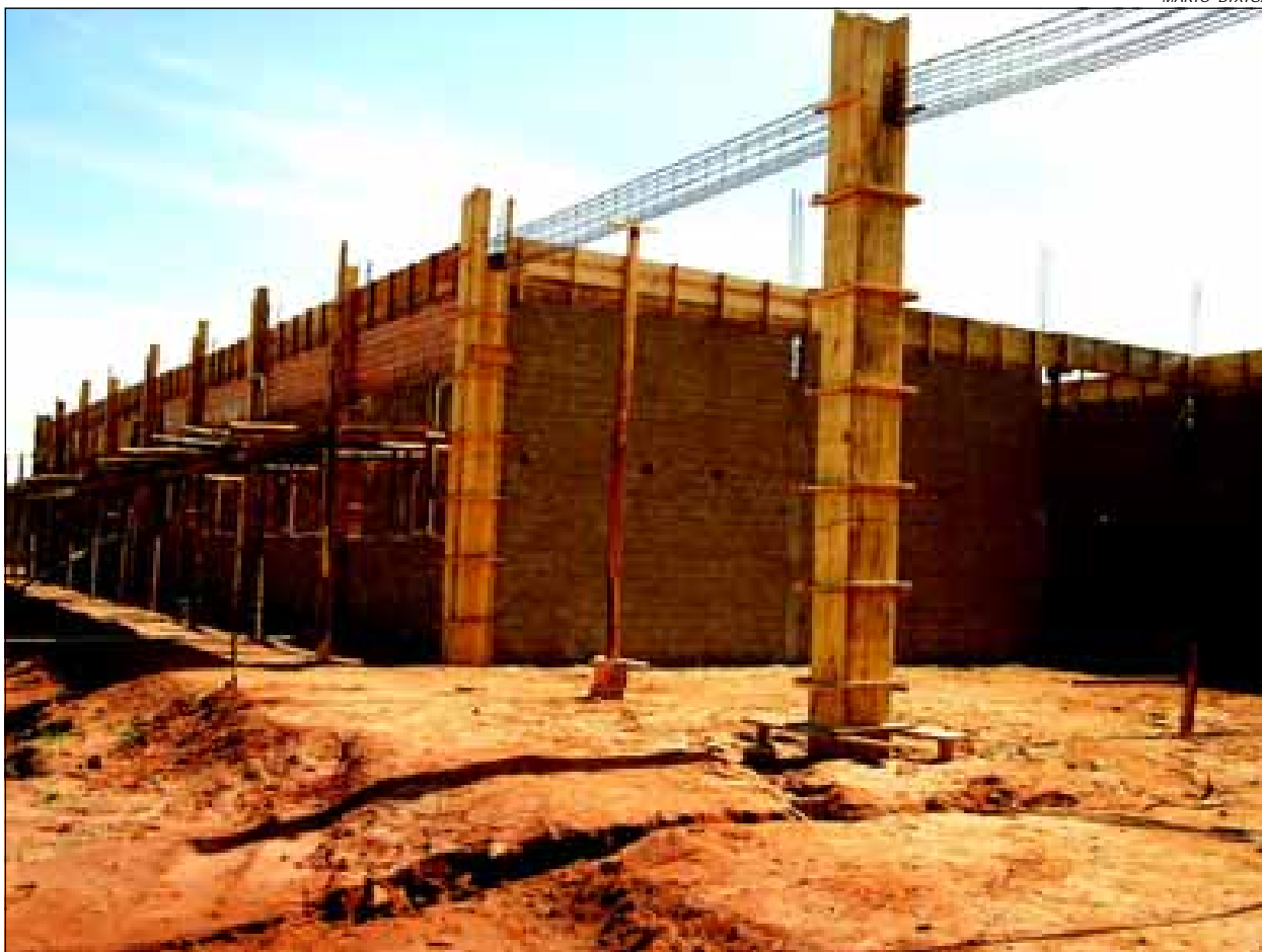
Obras da escola no Bairro Santa Mônica
